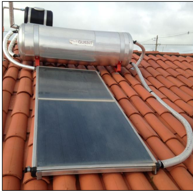
Figura 10 – MODELO RESIDENCIAL DE APROVEITAMENTO SOLAR TÉRMICO.
